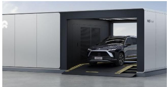
Figura 18: Estación de intercambio de baterías de VE 2.0 para vehículos de pasajeros Nio en China, Fuente: [33]
